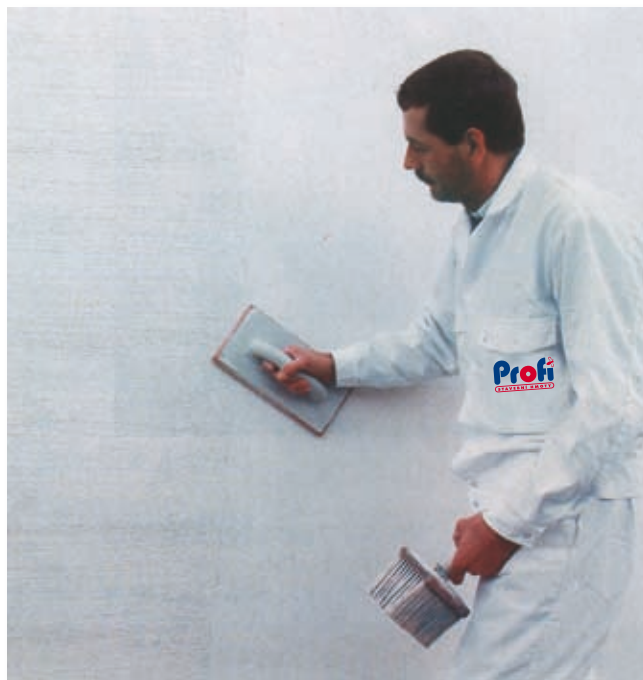
Provedení povrchové úpravy
