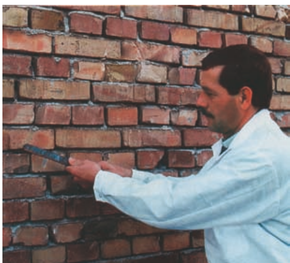
Příprava podkladu - proškrábnutí spár
