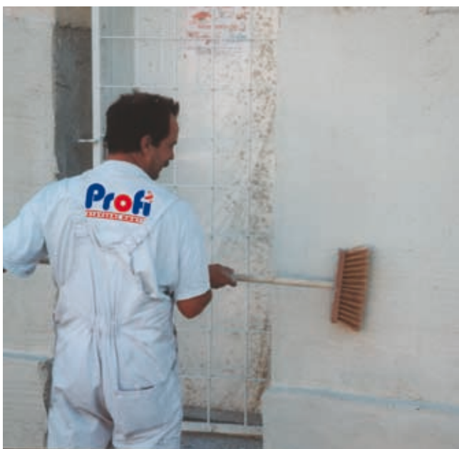
Zdrsnění povrchu omítky
