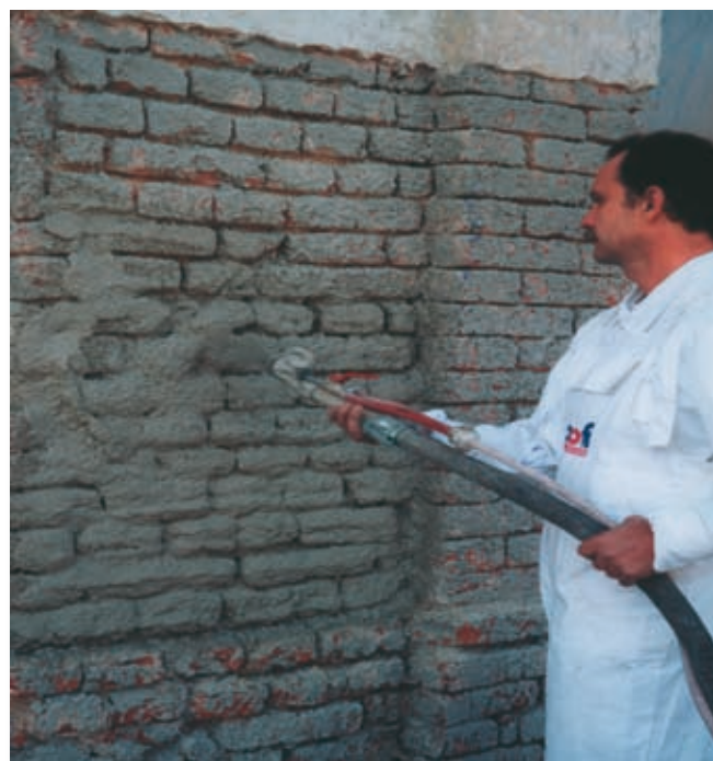
Strojní aplikace vyrovnávací vrstvy
