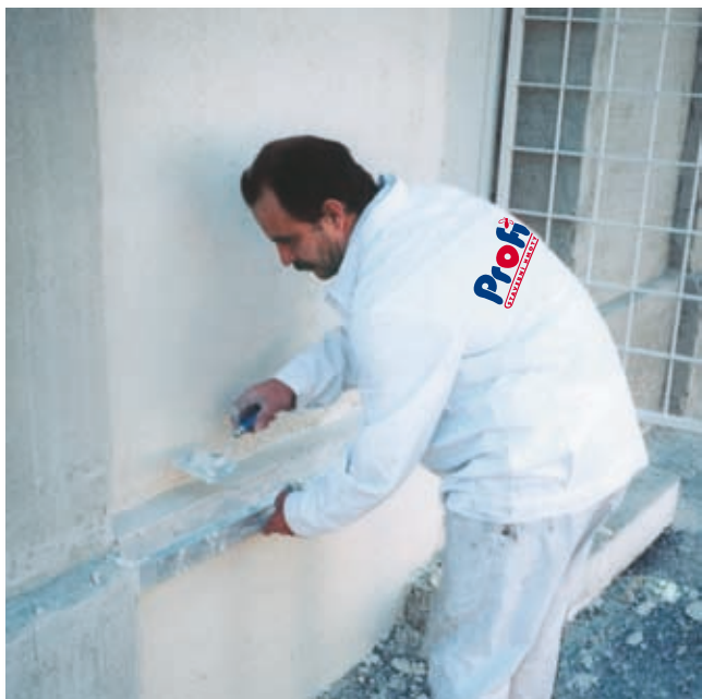
Ruční aplikace Profi Poretec WTA Sanierplus
