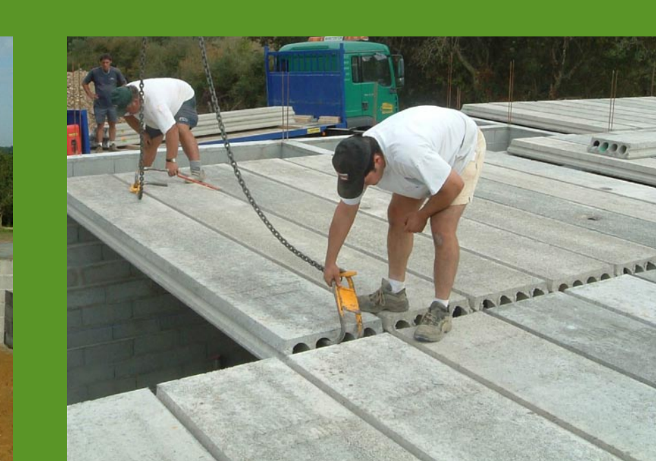
Dokončení pokládky T + 60 minut
