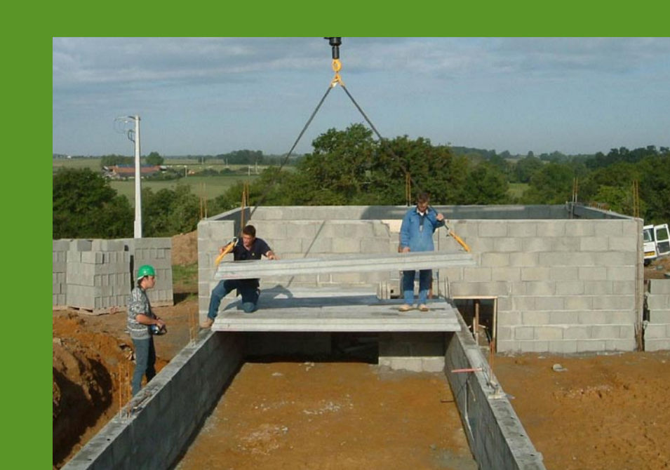
Pokládka prvních panelů T + 32 minut
