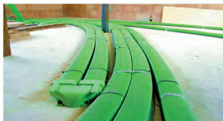
Instalace rozvodů v podlaze
