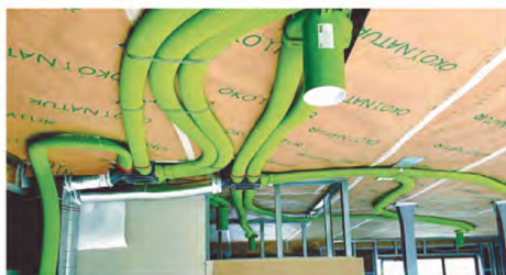
Instalace rozvodu do stropu, nízký profil = minimální navýšení
