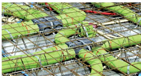
Instalace rozvodu do betonových monolitů
