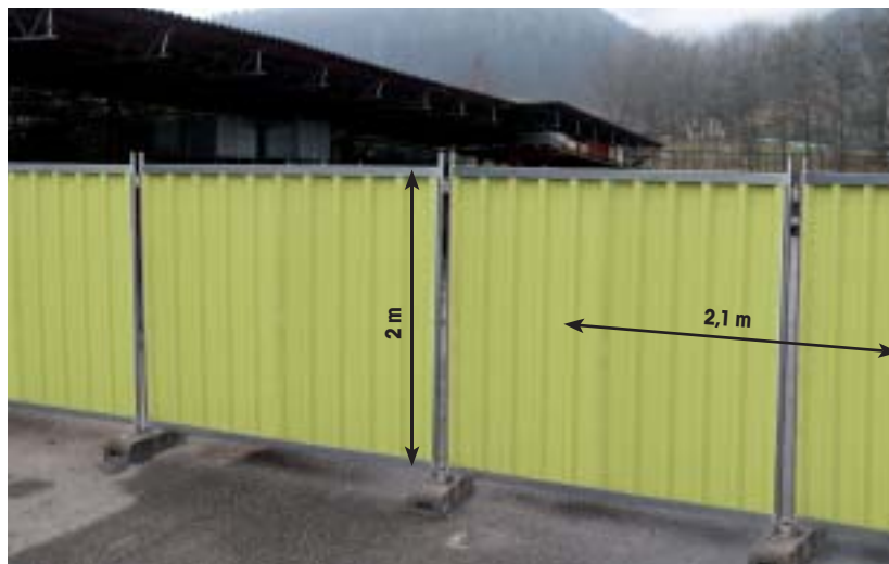
Stabilní pozinkovaný rám a lichoběžníkovýplech pro tu nejdelší životnost
