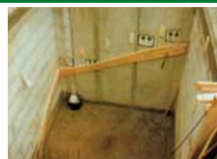
Na podoprenie teleskopických rúr pripevníme na bočné steny hranol hmoždinami 80x8mm
