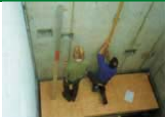
Výškové a smerové zameranie v priestore schodov
