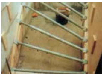
Montáž teleskopických rúr nasleduje
