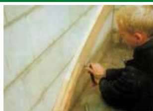
Na podoprenie teleskopických rúr pripevníme na bočné steny hranol hmoždinami 80x8mm
