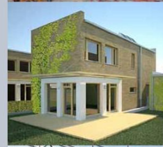
aktuální výstavba pasivních domů 2010
