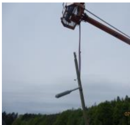
Stavění solárního svítidla
