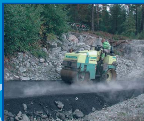
Kladení finální vrstvy po ručním překrytí topných kabelů
