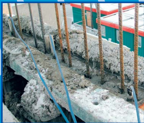
Vysoušení a vytvrzování první vrstvy betonu
