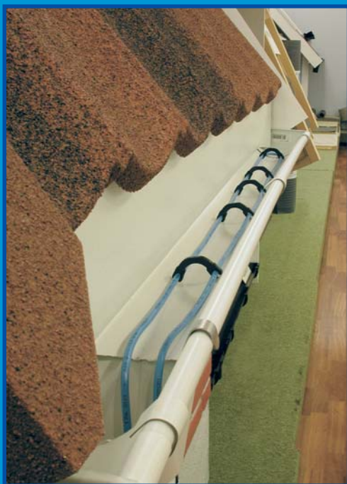
Dvě smyčky topného kabelu v plastových rozpěrkách
