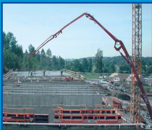
Staveniště v Bolasenu
